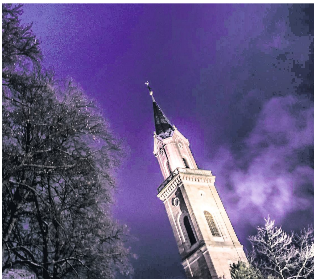
Die St.-Laurentius-Kirche in Weinheim bei Nacht: Sie ist künftig eine von vielen Kirchen der ehemals 14 eigenständigen Pfarreien, die spätestens 2026 die neue großflächige Pfarrei Bergstraße bilden werden.
